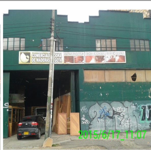
FACHADA DEL ESTABLECIMIENTO
