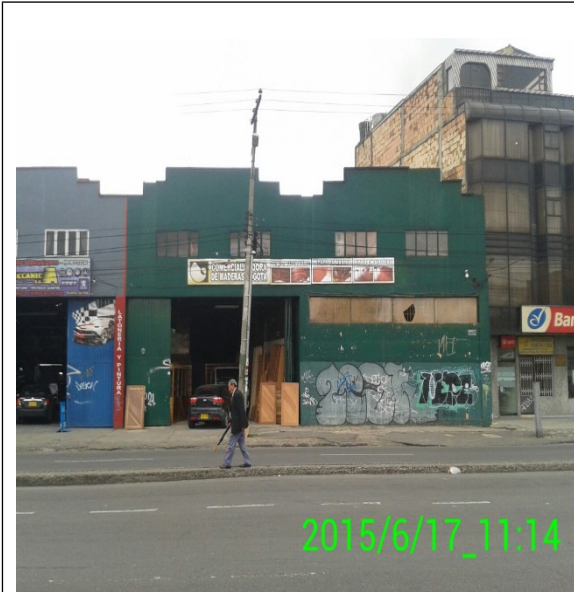
FACHADA DEL ESTABLECIMIENTO
