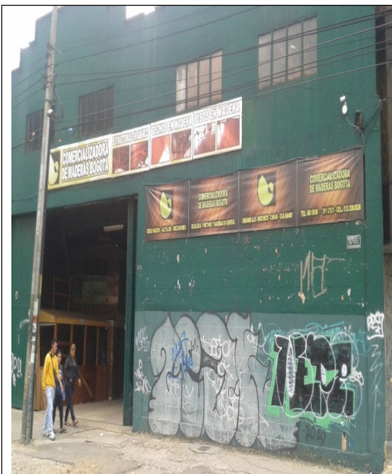
FACHADA DEL ESTABLECIMIENTO
