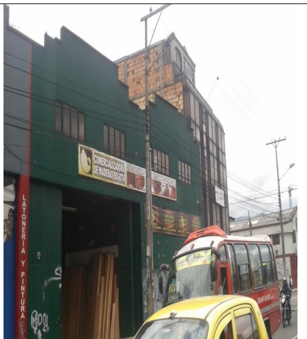
FACHADA DEL ESTABLECIMIENTO
